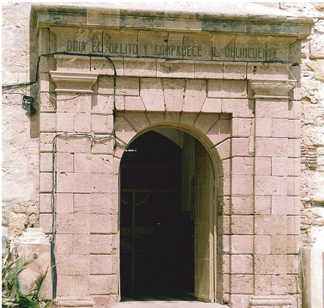
Img 18.8 - Portada de acceso al Fuerte de Victoria Grande
