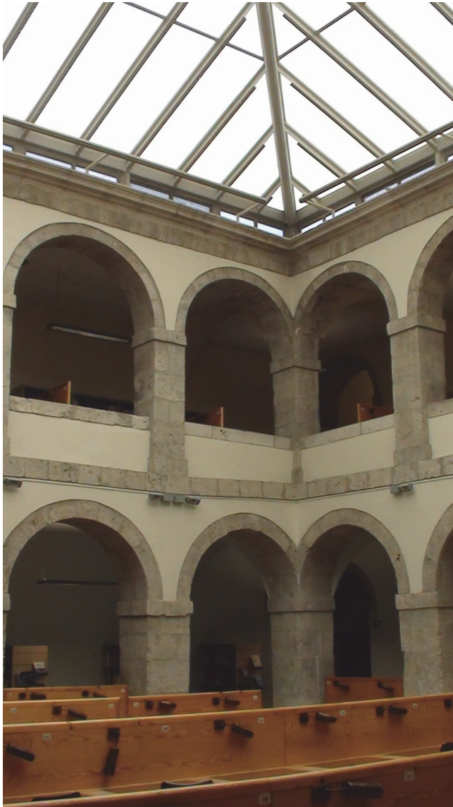
Img. 7.9- Cárcel Vieja. Nuevo lucernario en el patio
