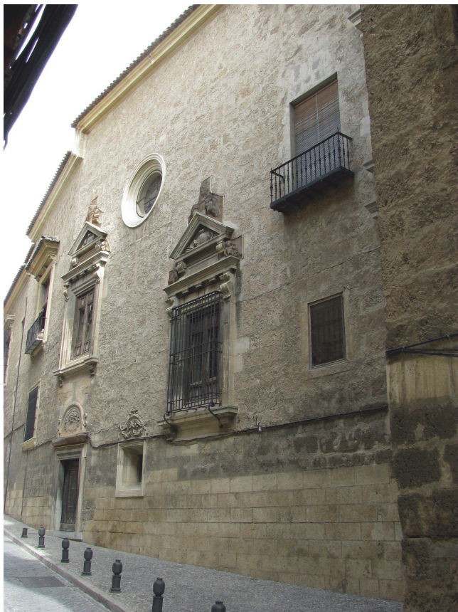
Img. 8.7 - Fachada lateral a la calle de la cárcel
