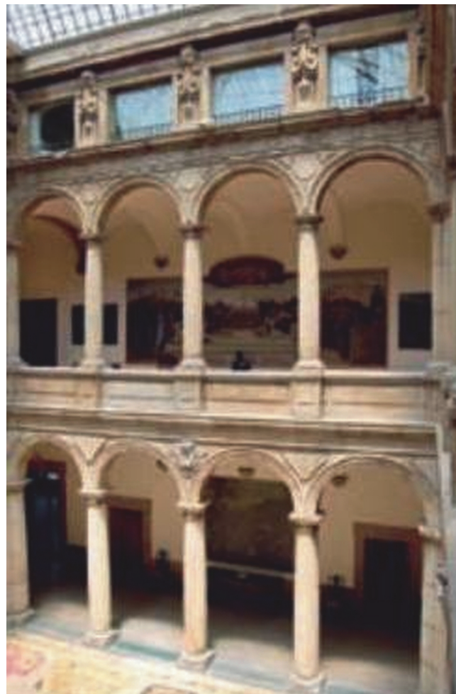
Img. 12.10.- Columnatas y arquerías de un patio
