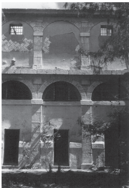
Img. 24.7.- Arquerías antes de la reforma
